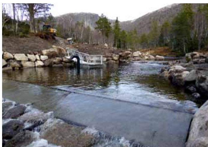
Inntaksdammen til Homme Kraftverk i Laugardalen vart ferdig hausten 2015
